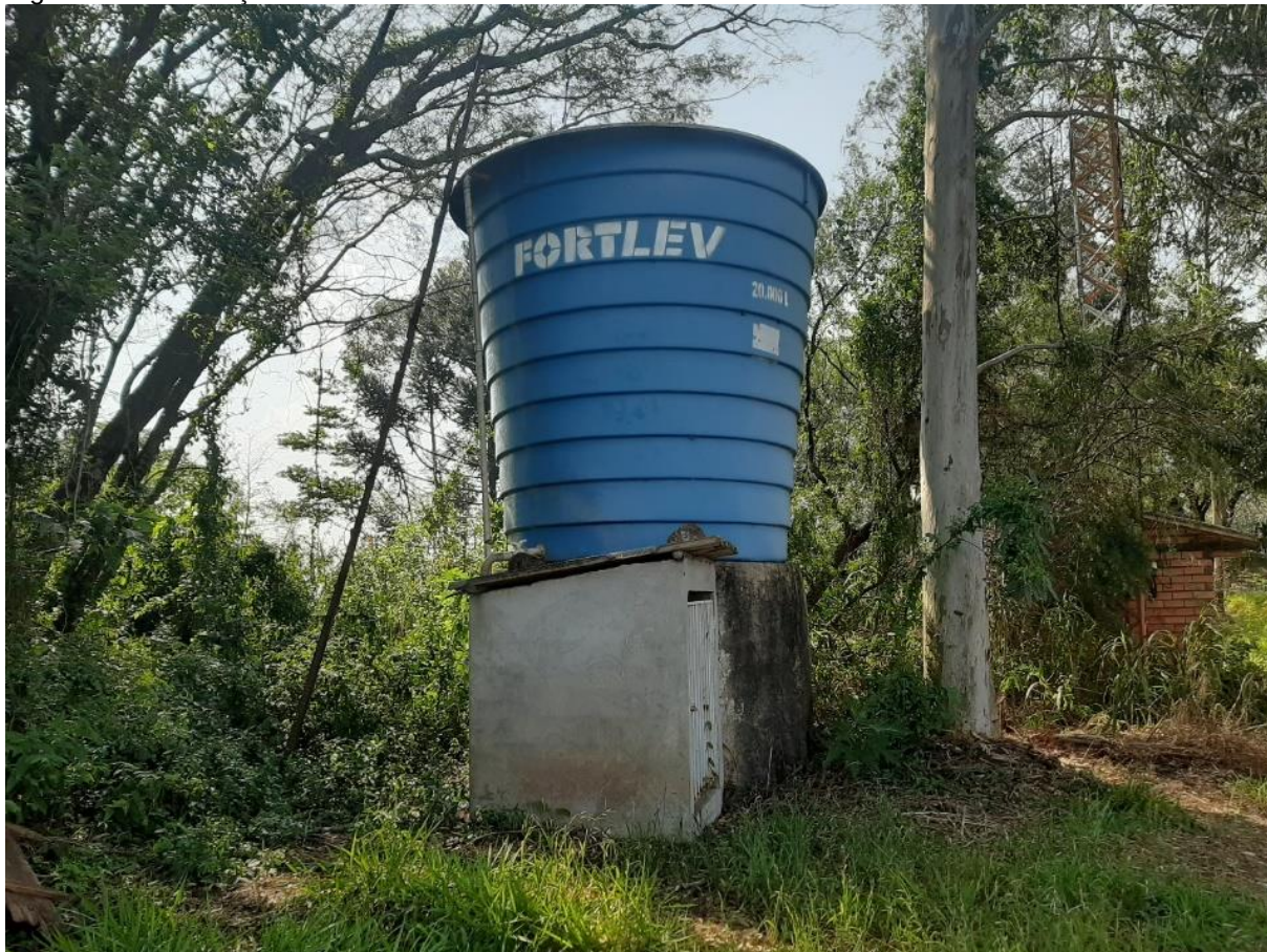
Figura 74: Reservação Linha Santana da Bela Vista – reservatório PRVF 20m³ - 09/2020.
