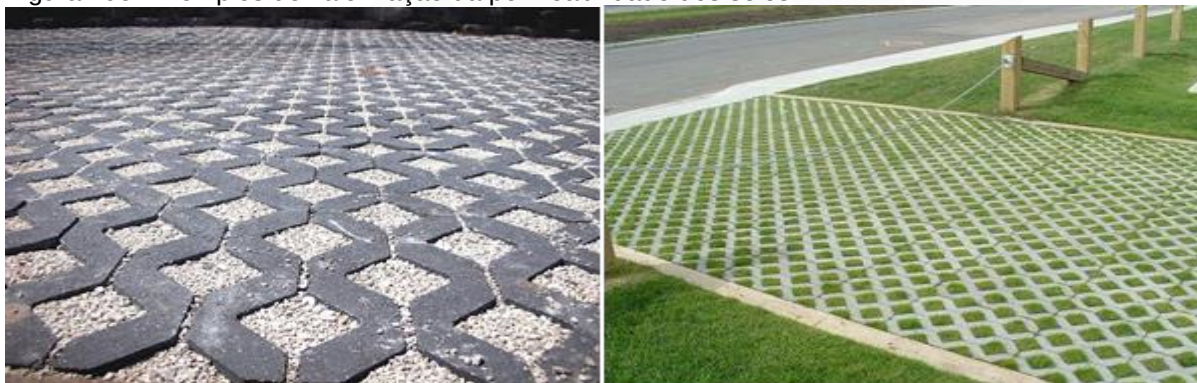
Figura 195: Exemplos de valorização da permeabilidade dos solos.
