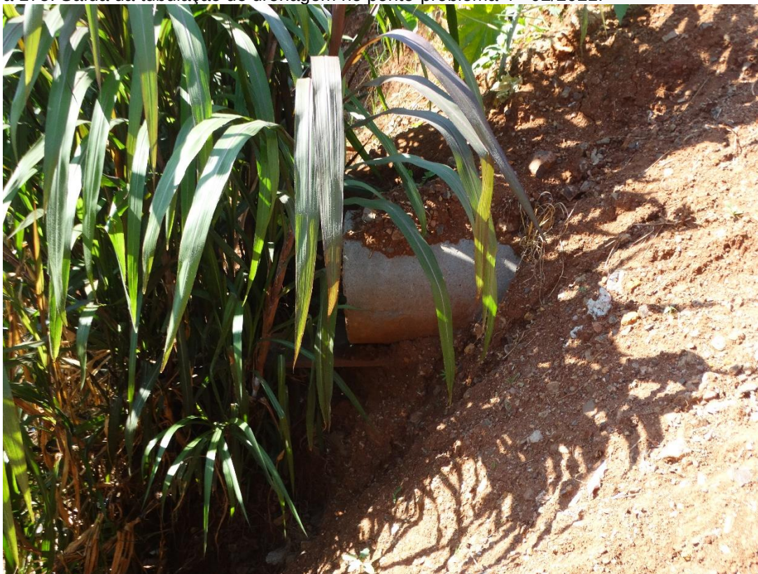
Figura 175: Saída da tubulação de drenagem no ponto-problema 4 - 02/2021.
