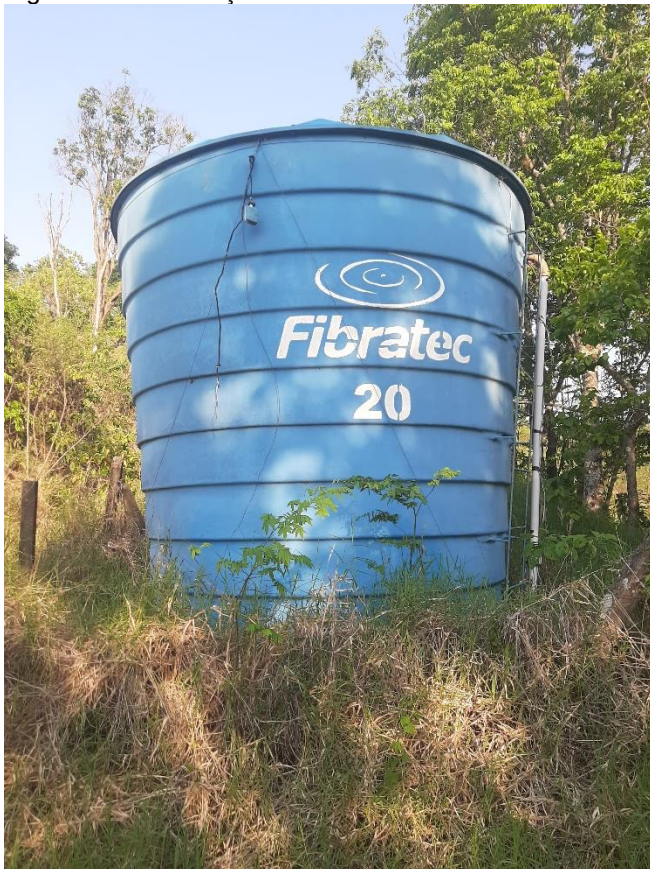
Figura 80:Reservação Linha Santa Inês– reservatório PRVF 20m³ - 09/2020.
