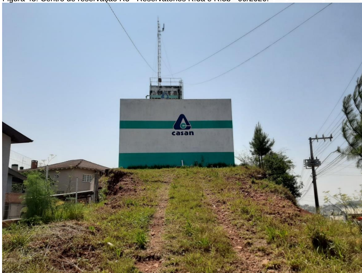
Figura 43: Centro de reservação R3 - Reservatórios R.3a e R.3b - 09/2020.
