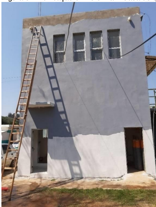
Figura 37: Edificação em reforma – Casa de química/Laboratório - 09/2020.
