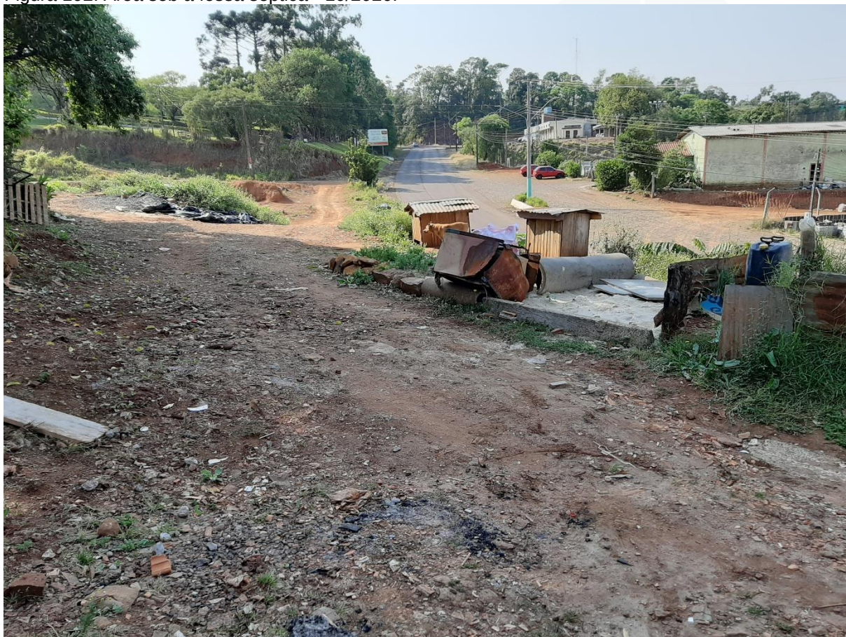
Figura 102: Área sob a fossa séptica - 10/2020.
