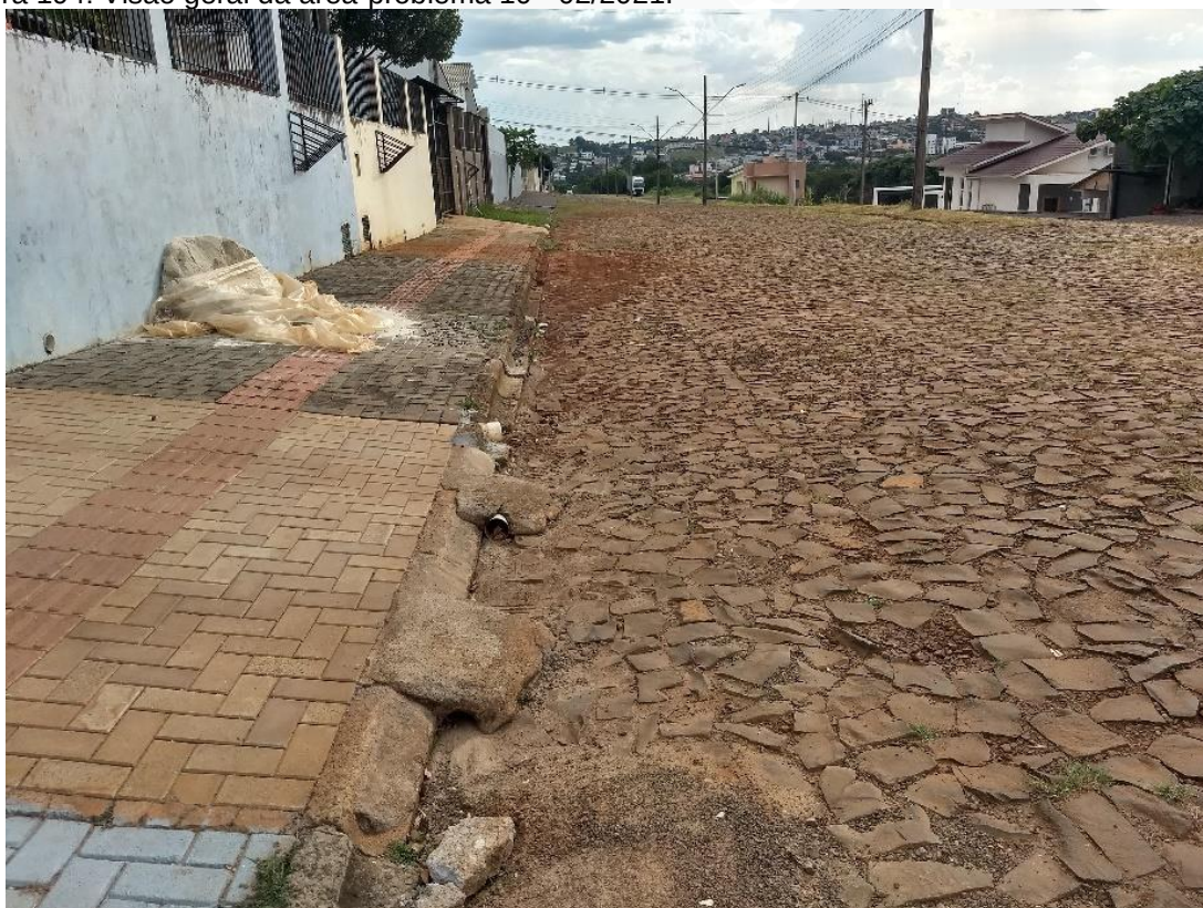
Figura 194: Visão geral da área-problema 10 - 02/2021.
