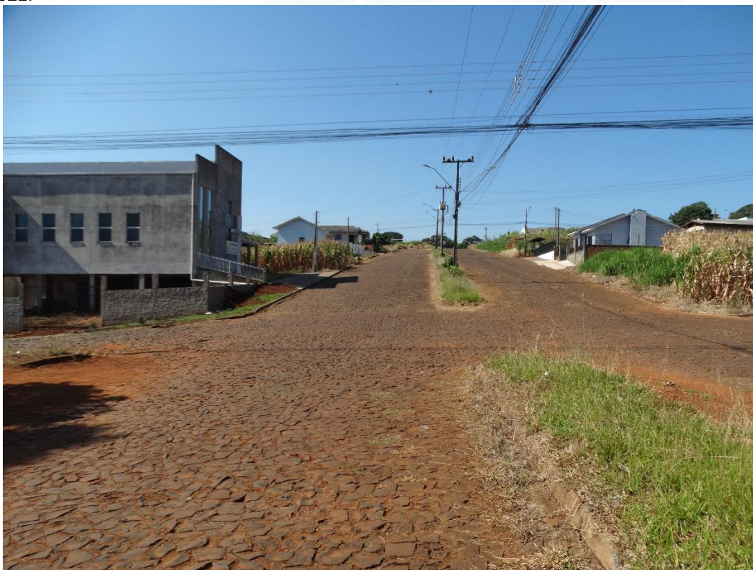
Figura 180: Área de contribuição da área-problema de alagamento na Rua Domingos Cateneo Fabro - 02/2021.
