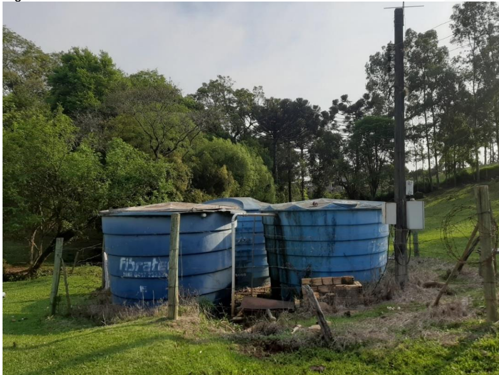
Figura 63: Reservatório em PRFV de 15 m 3 cada - 09/2020.
