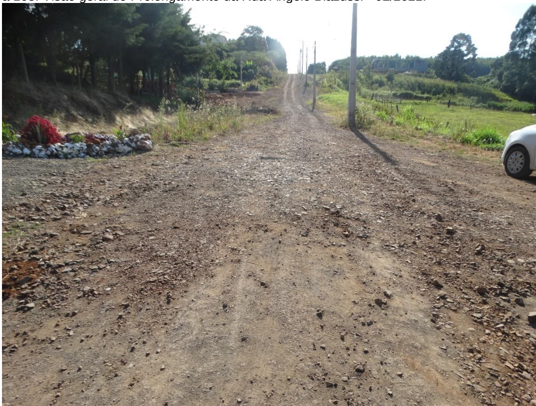
Figura 168: Visão geral do Prolongamento da Rua Ângelo Biazussi - 02/2021.
