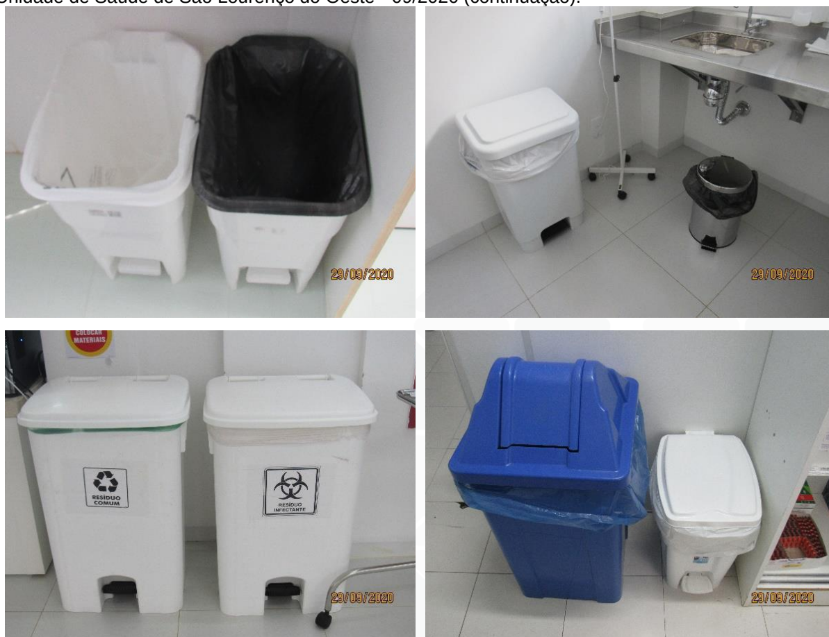
Figura 134: Tipos de lixeiras e sacos utilizados para a segregação de RSS e resíduos comuns nas Unidade de Saúde de São Lourenço do Oeste - 09/2020 (continuação).
