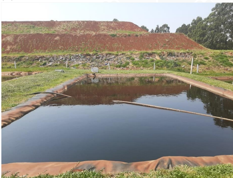
Figura 124: Uma das 8 lagoas de tratamento de efluentes que compõem o sistema de tratamento de percolado - 09/2020.
