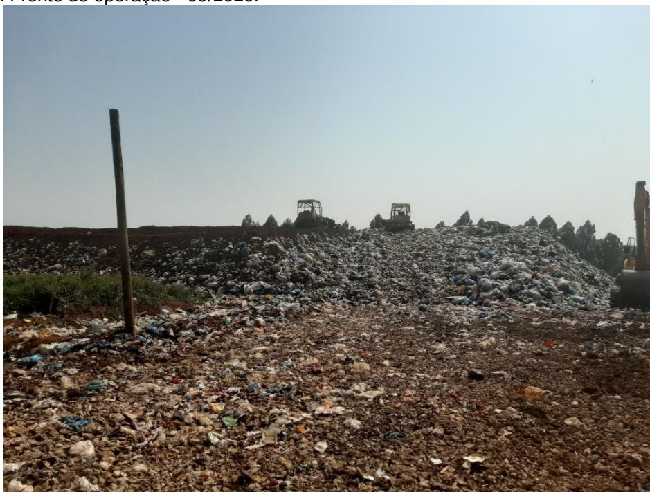
Figura 117: Frente de operação - 09/2020.
