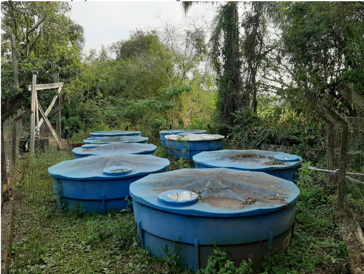
Figura 89: Reservação para abastecimento emergencial – Clube Bela Vista - 09/2020.
