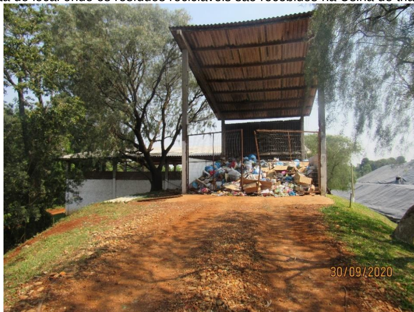
Figura 130: Vista do local onde os resíduos recicláveis são recebidos na Usina de triagem - 09/2020.
