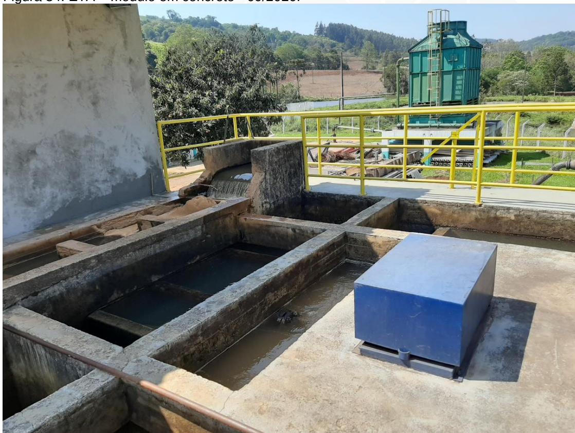
Figura 34: ETA – módulo em concreto - 09/2020.
