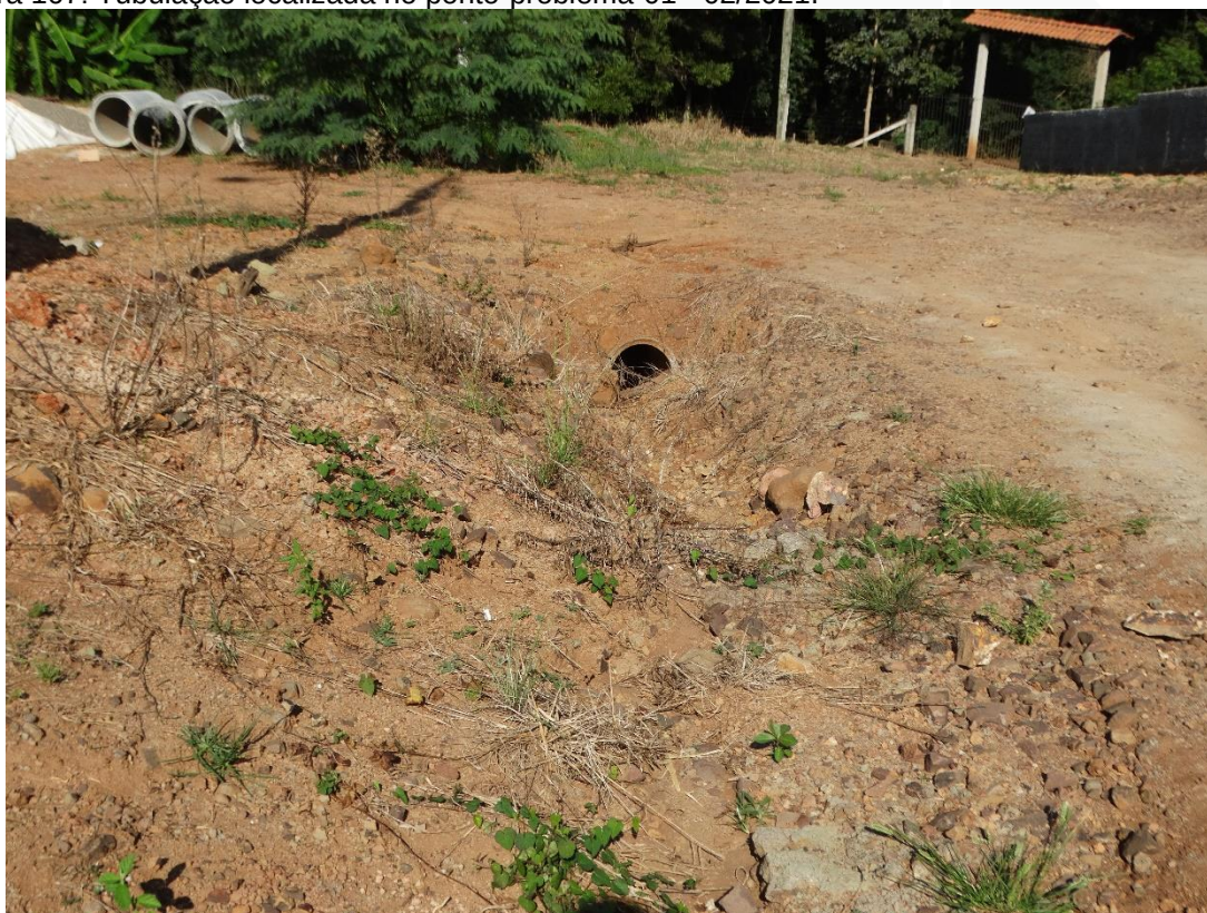
Figura 167: Tubulação localizada no ponto-problema-01 - 02/2021.
