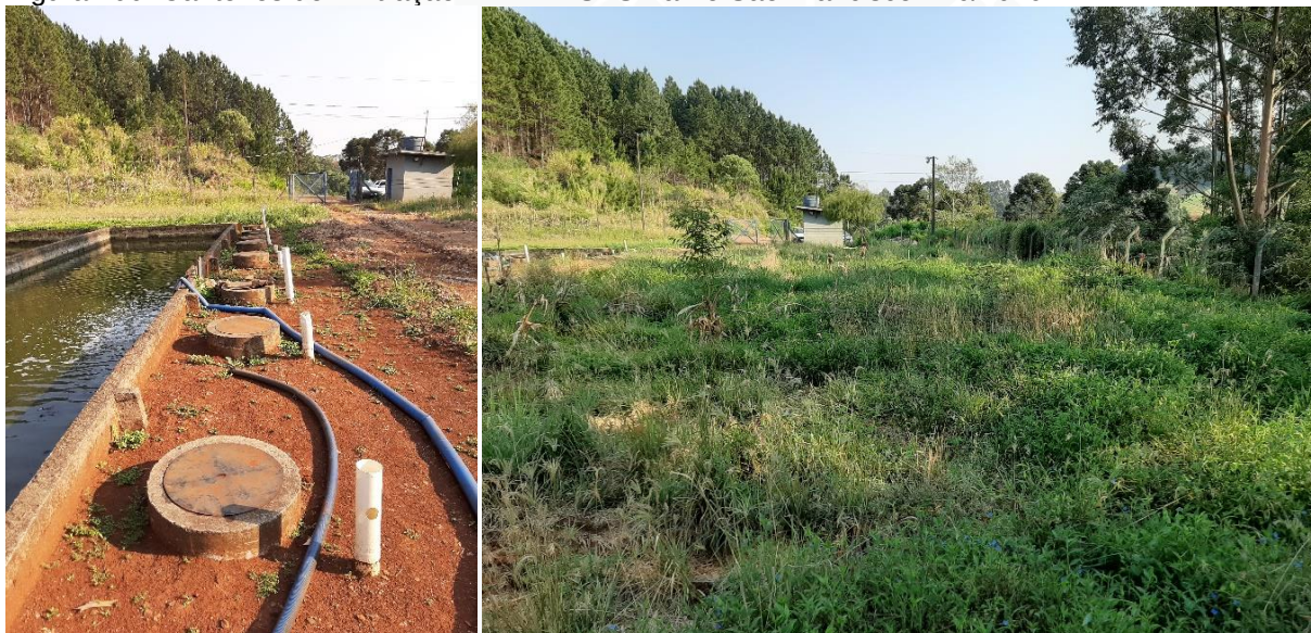
Figura 100: Canteiros de infiltração – ETE – SES Bairro São Francisco - 10/2020.
