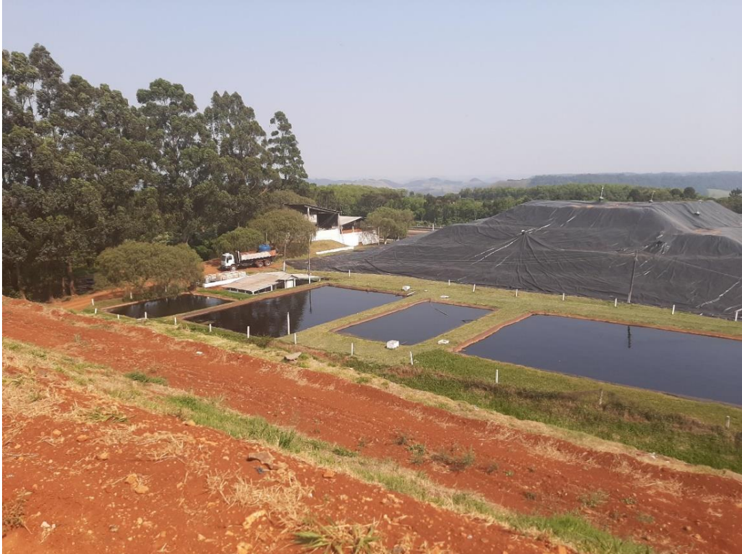
Figura 125: Representação de 4 lagoas, parte do sistema de tratamento de efluentes - 09/2020.
