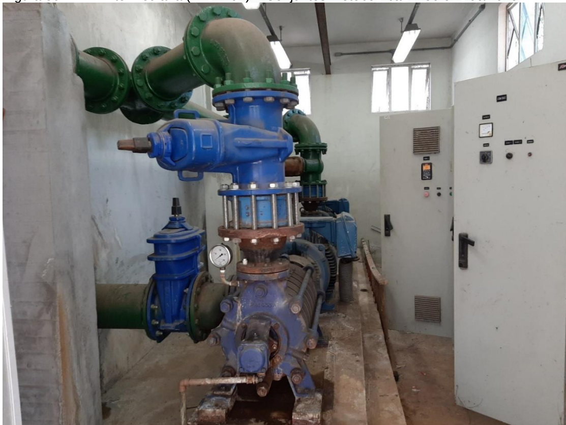
Figura 50: ERAT intermediária (ERAT 02) – Conjuntos motobomba – 150 cv - 09/2020.
