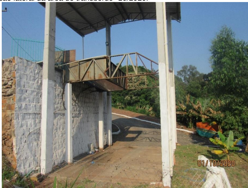
Figura 112: Visão lateral da área de transbordo -10/2020.
