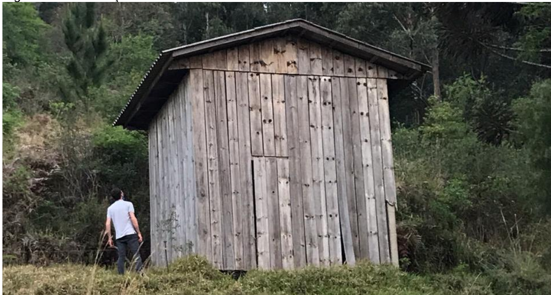
Figura 60: Reservação – SAA Distrito de Frederico Wastner – Reservatório em PRFV 20 m³ - 09/2020.
