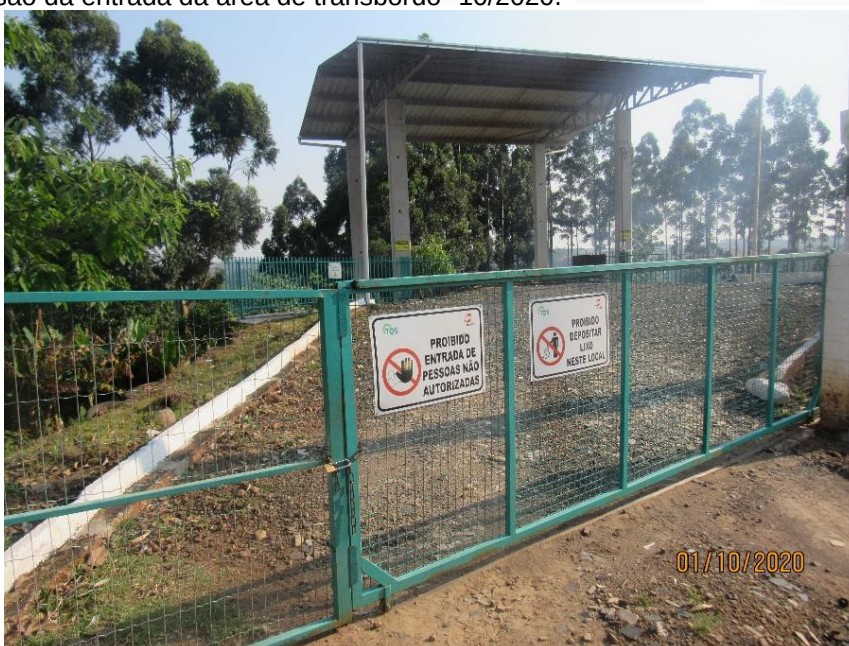
Figura 111: Visão da entrada da área de transbordo -10/2020.
