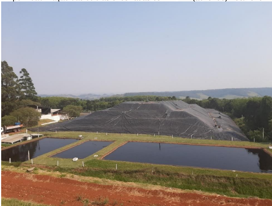
Figura 120: Impermeabilização das células encerradas com PEAD (ao fundo) - 09/2020.
