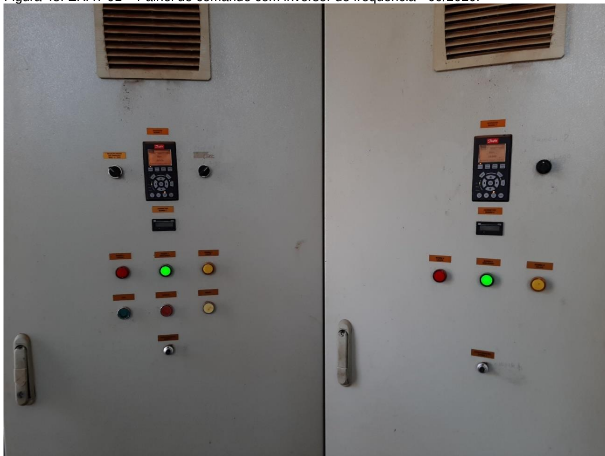
Figura 48: ERAT 01 – Painel de comando com inversor de frequência - 09/2020.
