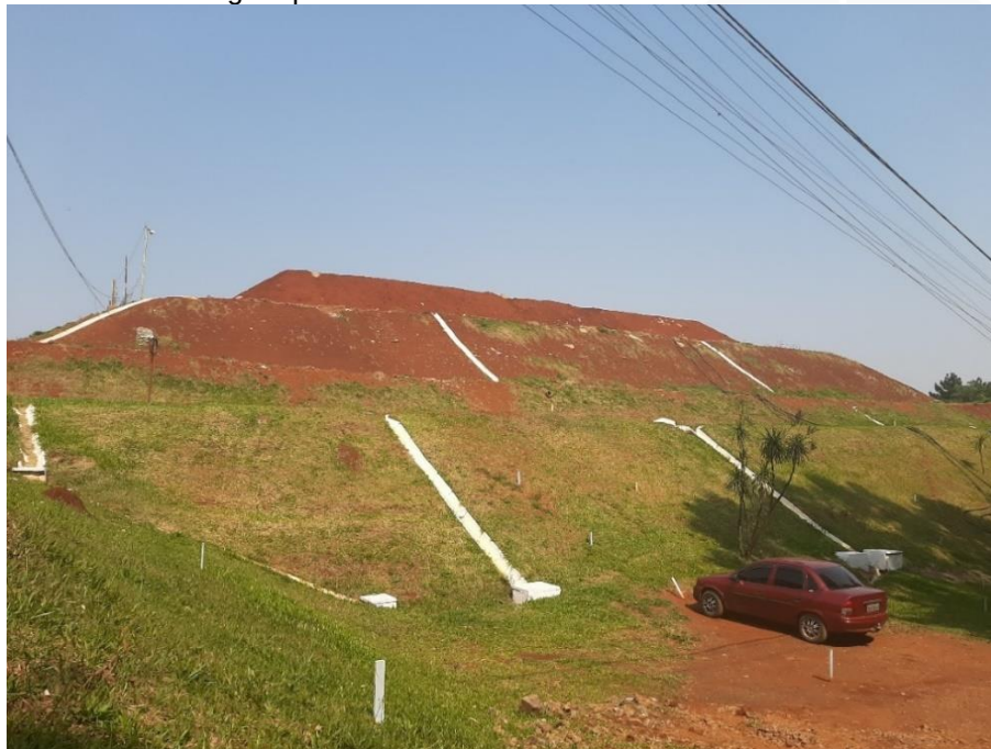
Figura 121: Sistema de drenagem pluvial instalado no aterro - 09/2020.
