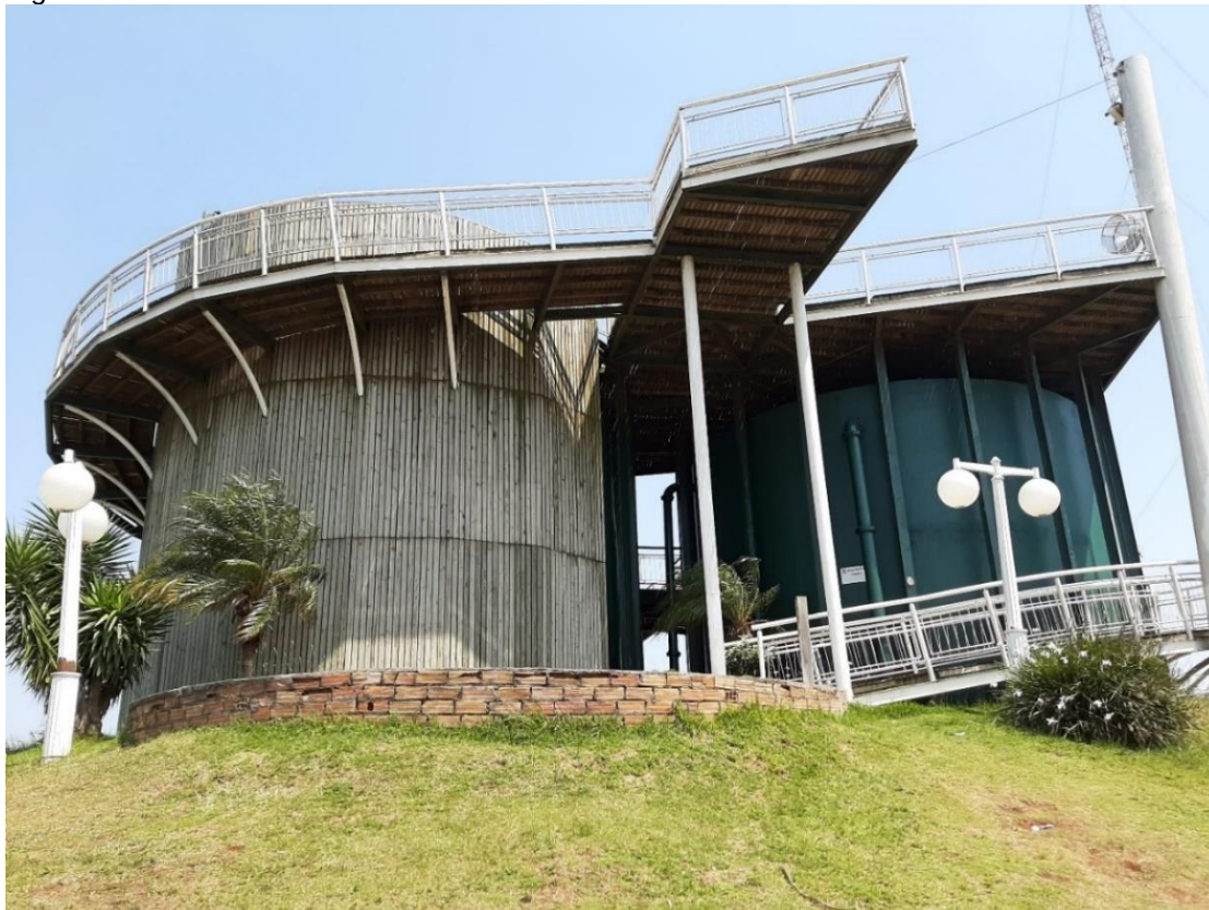
Figura 41: Reservatórios R.1 e R.2 - 09/2020.
