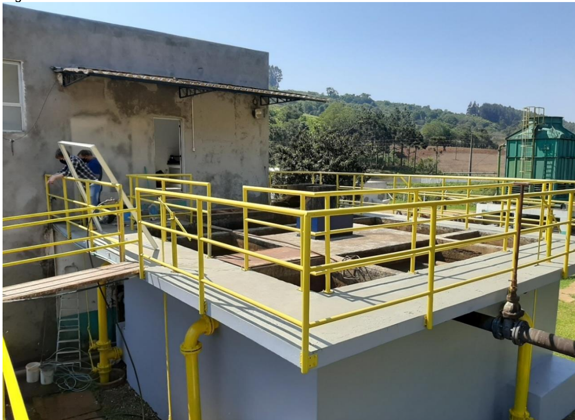
Figura 33: ETA – módulo em concreto - 09/2020.
