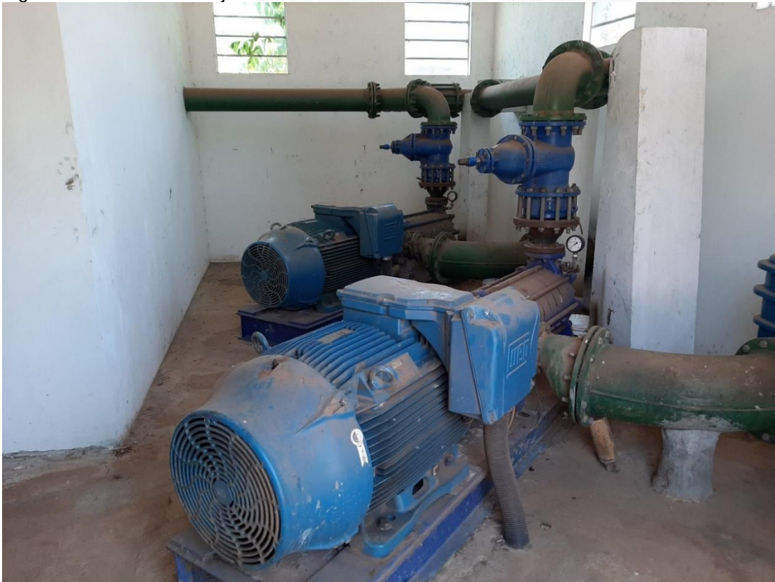
Figura 47: ERAT 01 – Conjuntos motobomba 200 cv - 09/2020.
