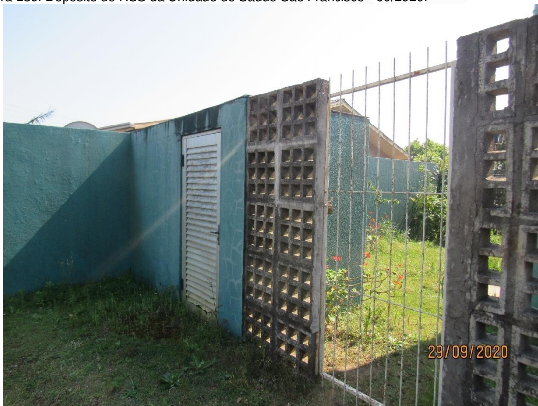
Figura 135: Depósito de RSS da Unidade de Saúde São Francisco - 09/2020.
