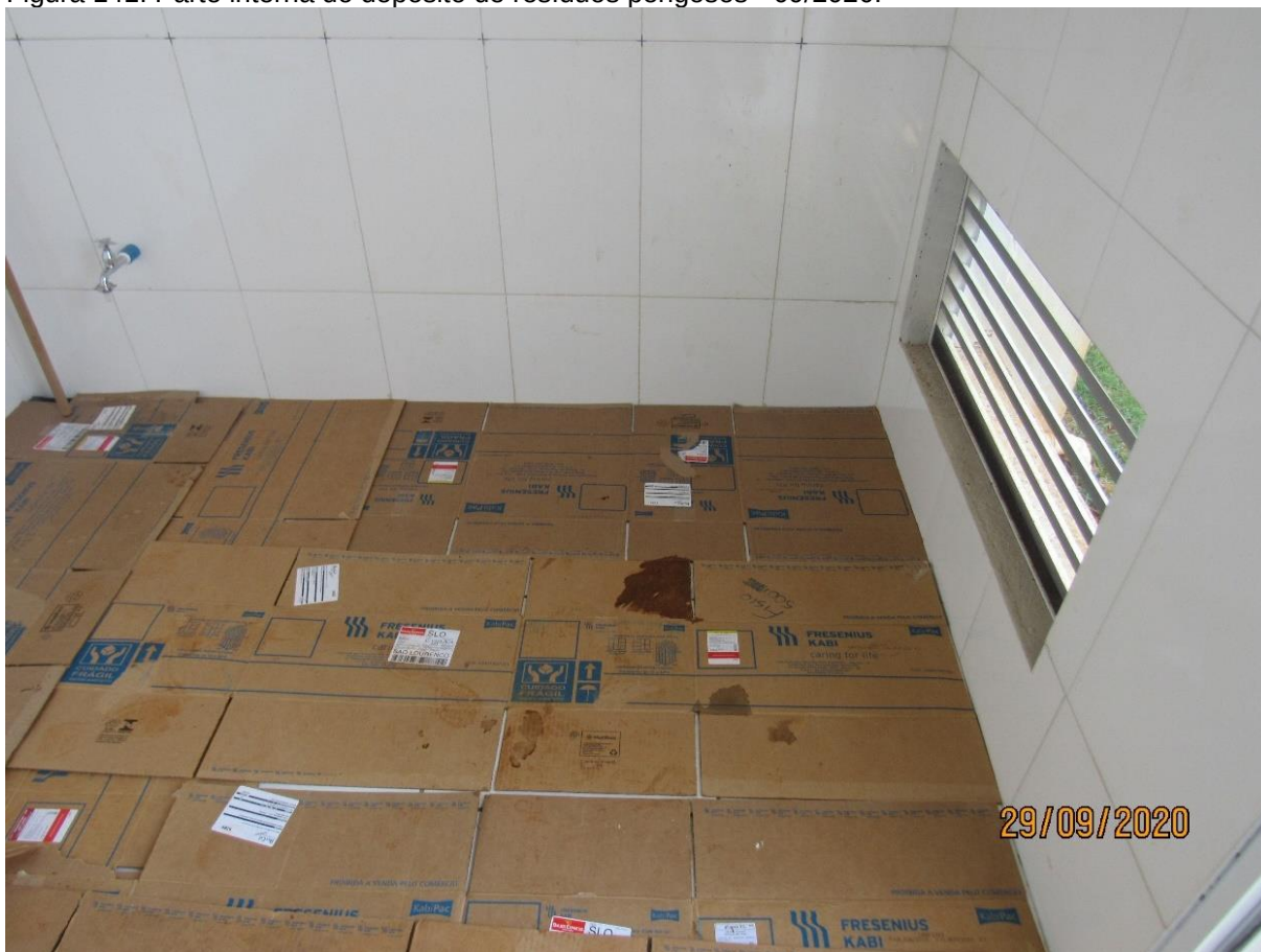
Figura 141: Parte interna do depósito de resíduos perigosos - 09/2020.
