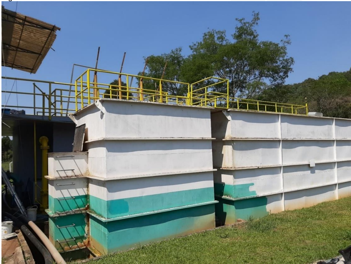
Figura 35: ETA metálica – vista lateral - 09/2020.
