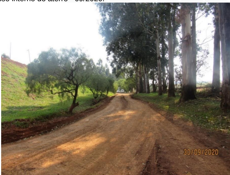
Figura 116: Acesso interno do aterro - 09/2020.
